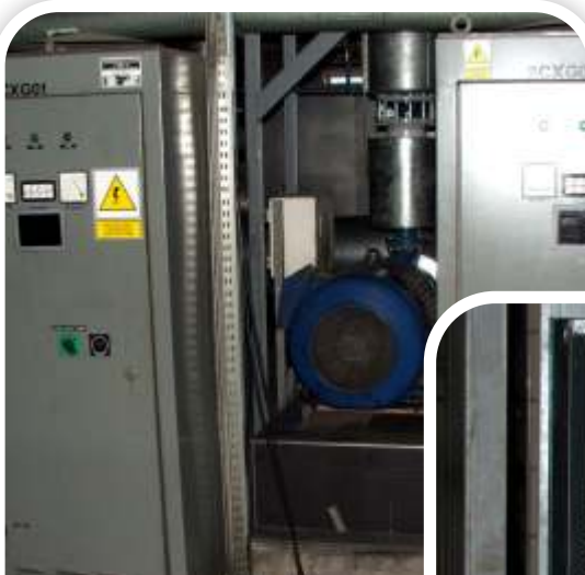
Zdjęcie 8. Falowniki Pomp sieciowych przed realizacją projektu
