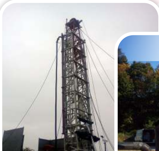
Zdjęcie 1. Przebudowa odwiertu chłonnego – urządzenie wiertnicze
